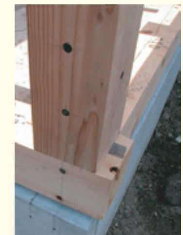
柱をセットしてピンを打ち込む。見えるのはピンだけなのでスッキリします。
