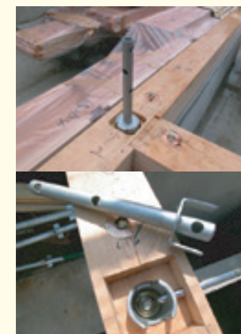
ホールダウン金物のHDCと笠形アンカーボルト。柱・土台・基礎を緊結します。
