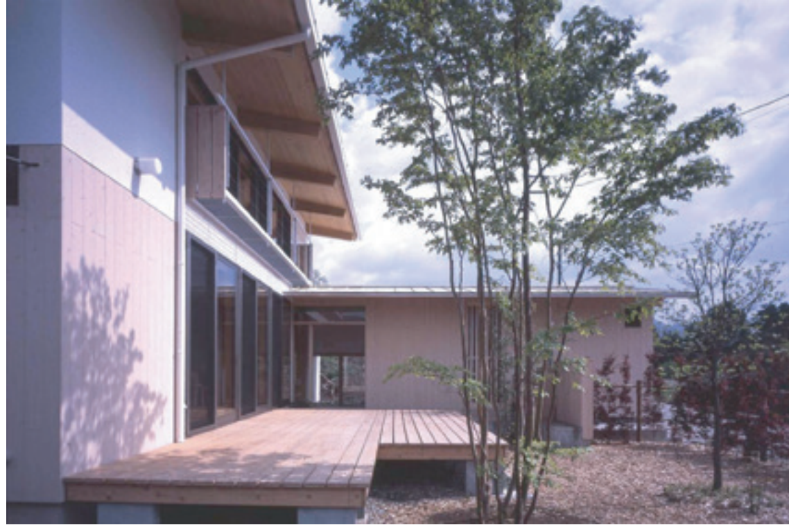
神奈川のM邸。夏の日差しを遮り家を雨から守る深い軒は強いJパネルならではの、持ち出した梁にしっかりと金物で留めて風の吹き上げを押えています。軒裏の表情も美しくなります。
