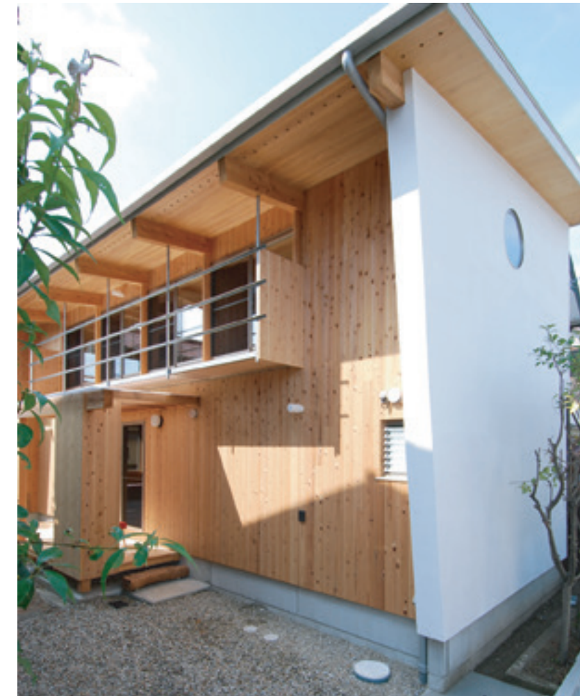
軒裏もJパネルあらわしで防火構造になります。Jパネルが厚板であることと、軒から室内に火が入らないように面戸板を45mm以上にすることで可能になっています。(H12建設省告示第1358号)
