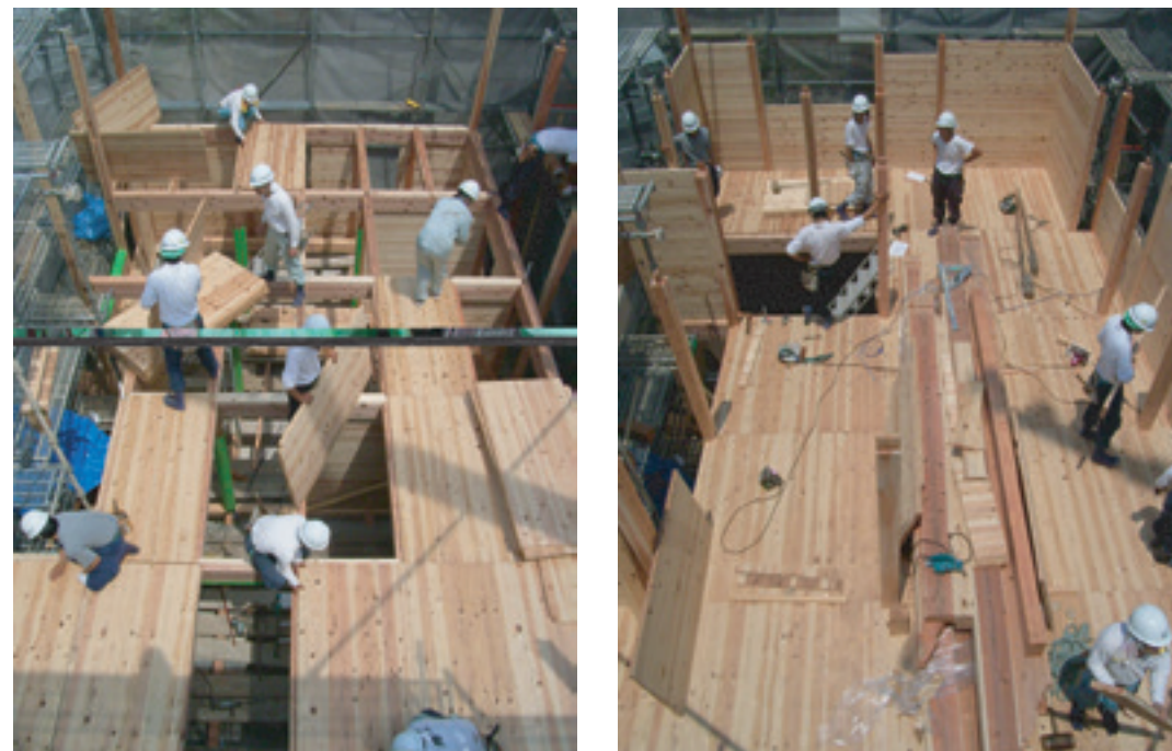
建て方の様子。Jパネルで床を造りながら工事を進めれば、足場にもなり作業性も安定します。
