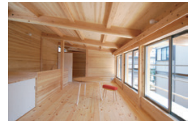
軒裏もJパネルあらわしで防火構造になります。Jパネルが厚板であることと、軒から室内に火が入らないように面戸板を45mm以上にすることで可能になっています。(H12建設省告示第1358号)
